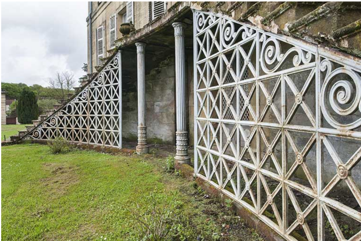
Structure métallique soutenant l'escalier.
