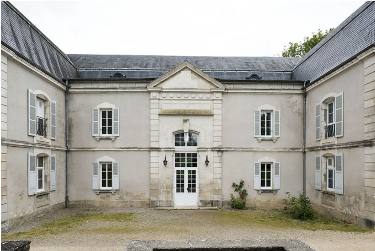
Vue sur la travée centrale
