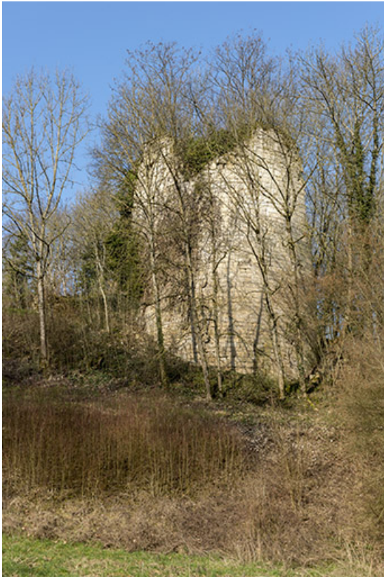
Tour nord en ruine.
