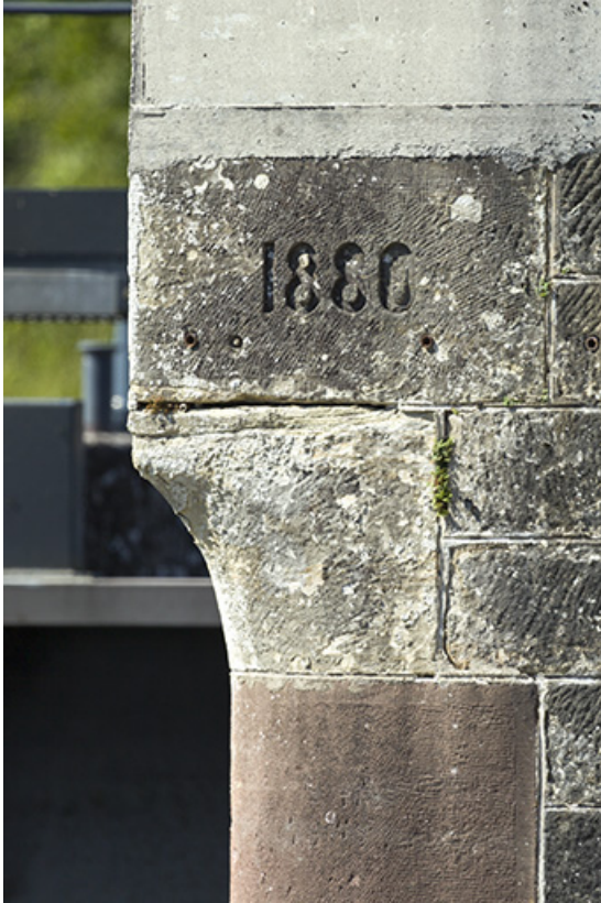
Date portée 1880 dans la maçonnerie (aval).
