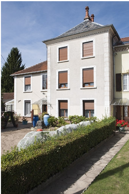
Façade antérieure, partie ouest.
