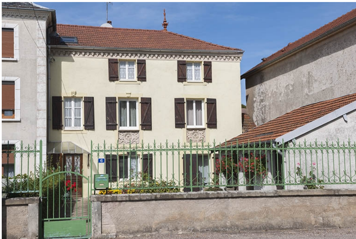
Façade antérieure, partie est.
