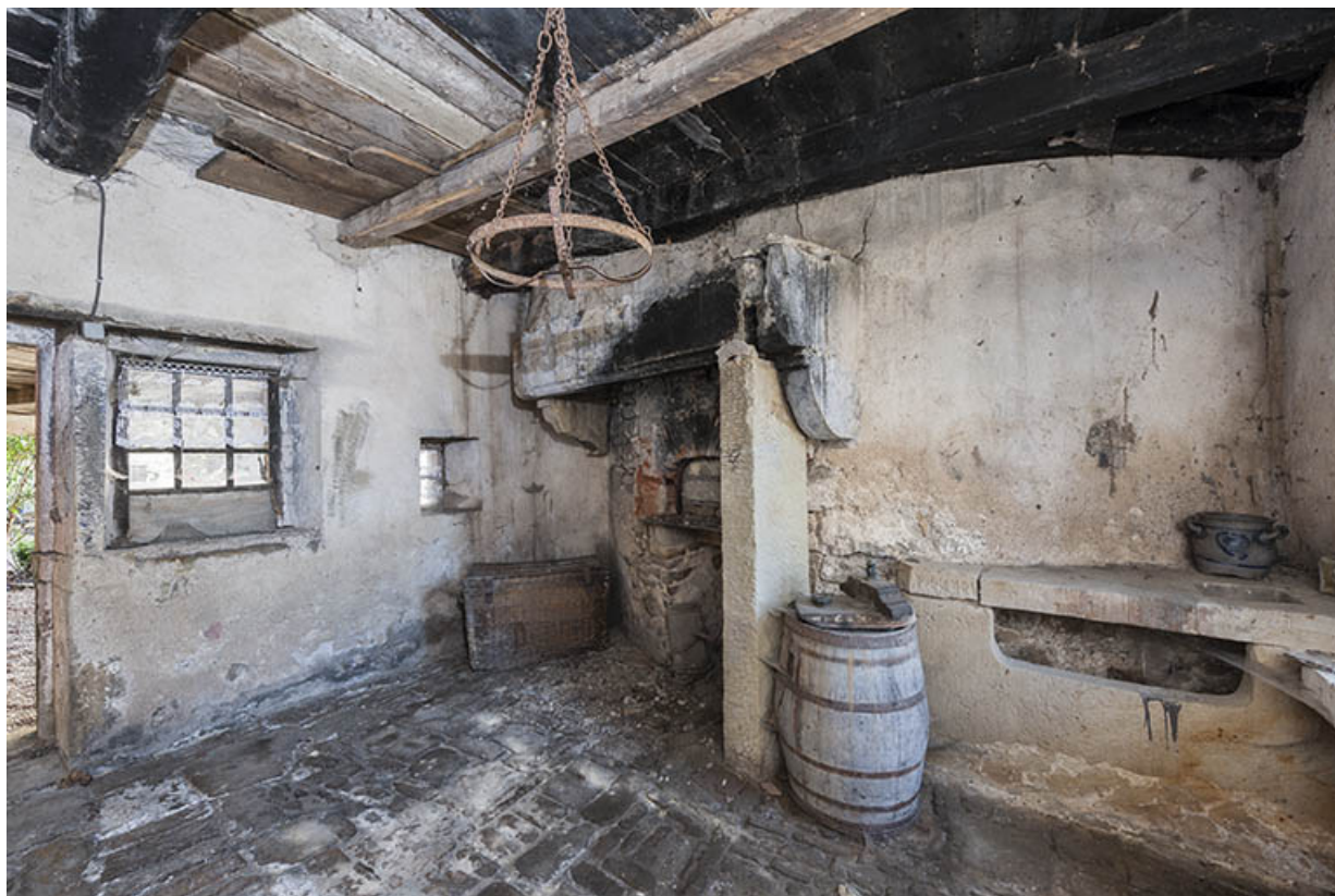
Rez-de-chaussée du pigeonnier circulaire.
