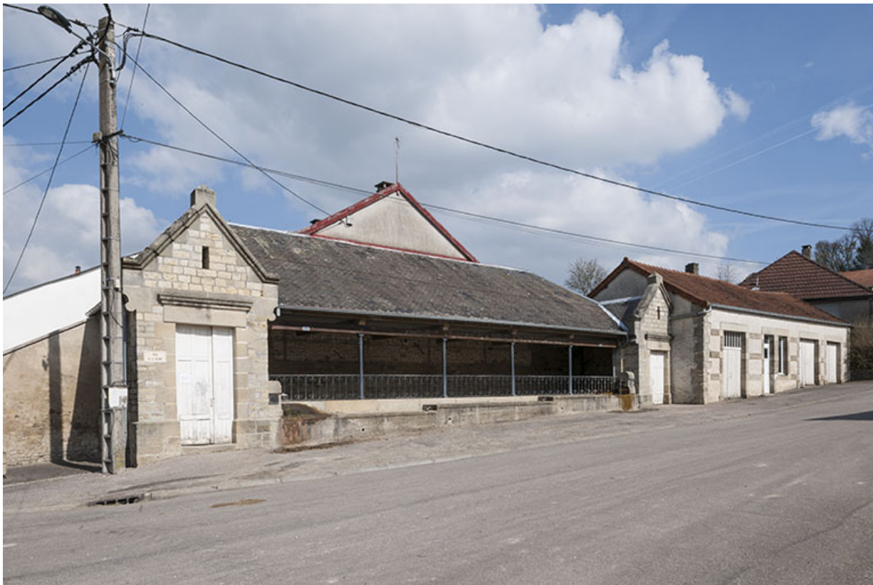
Le lavoir, rue de la Vigne.
