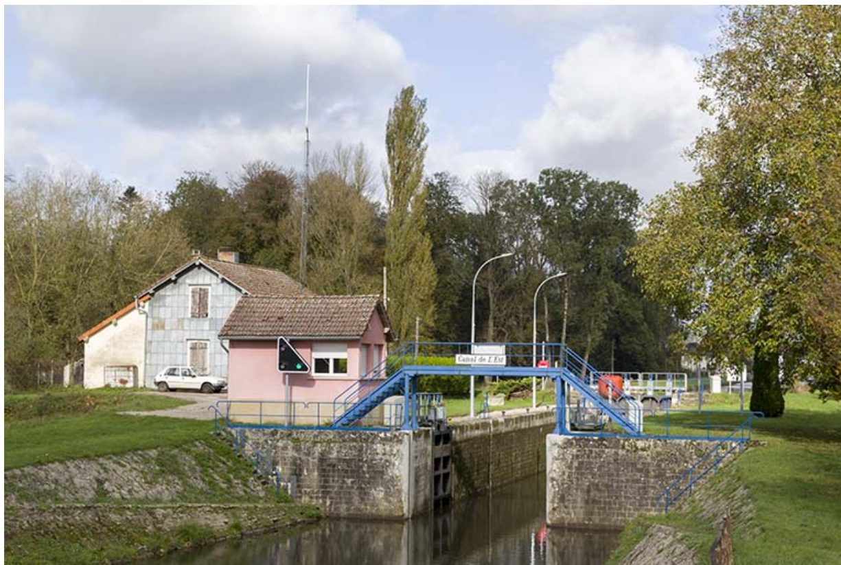
Vue du site d'écluse depuis l'aval.
