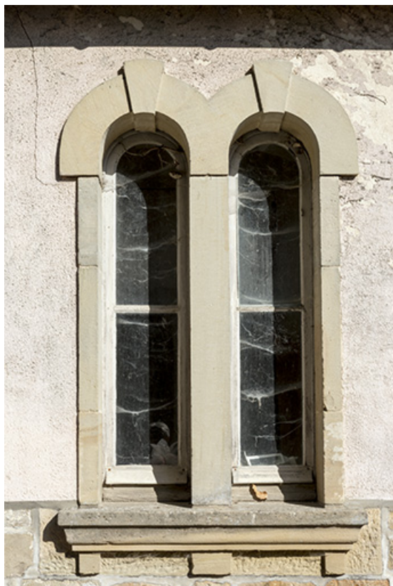
Détail des baies jumelées de l'ancienne dépendance.
