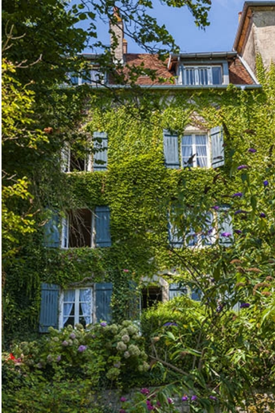
Façade postérieure, côté canal du Moulin.
