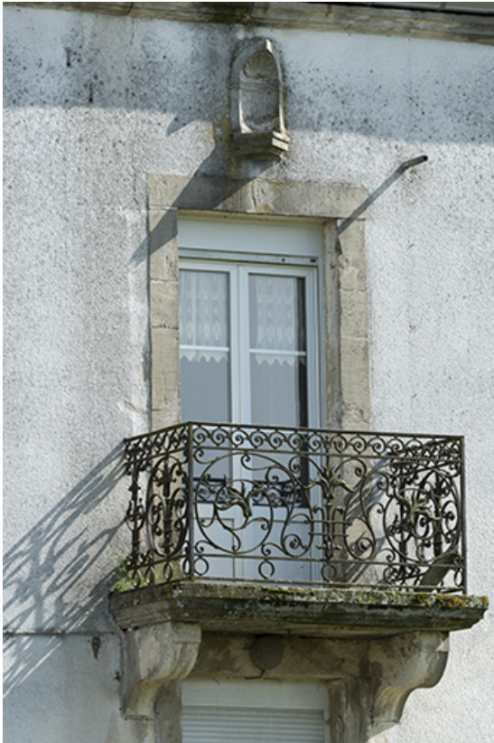
Détail d'une baie.
