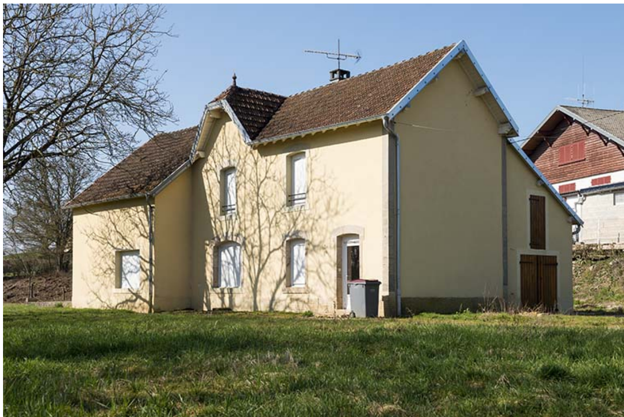
Ancienne halte ferroviaire.
