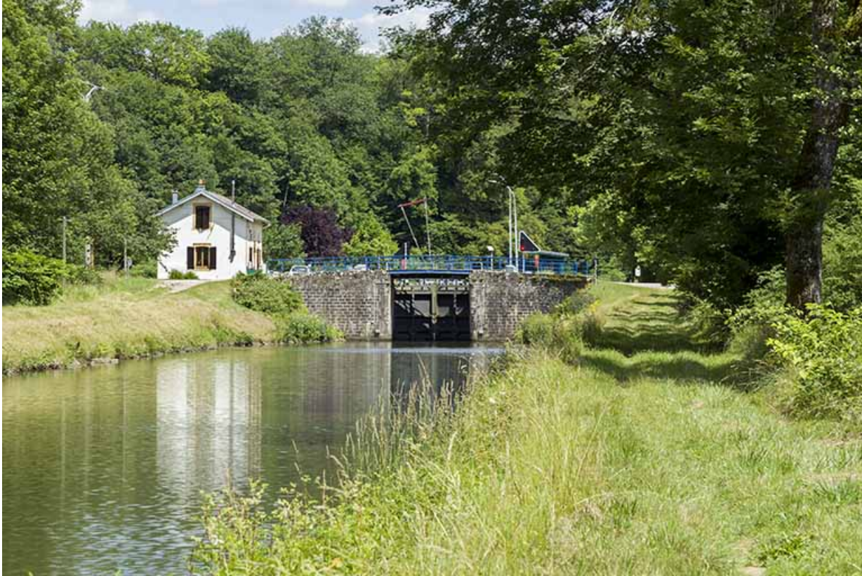
Vue d'ensemble depuis l'aval.
