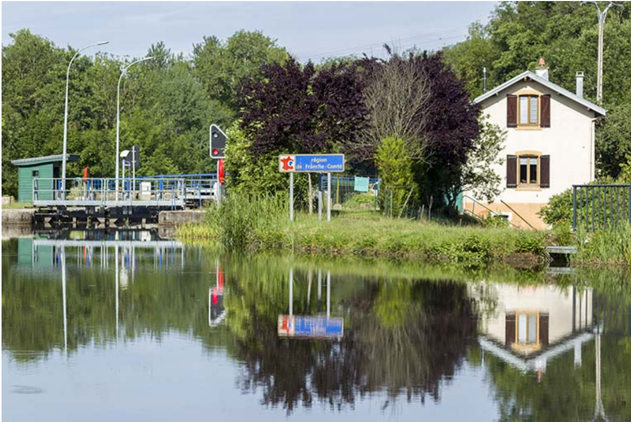
Vue d'ensemble depuis l'amont.
