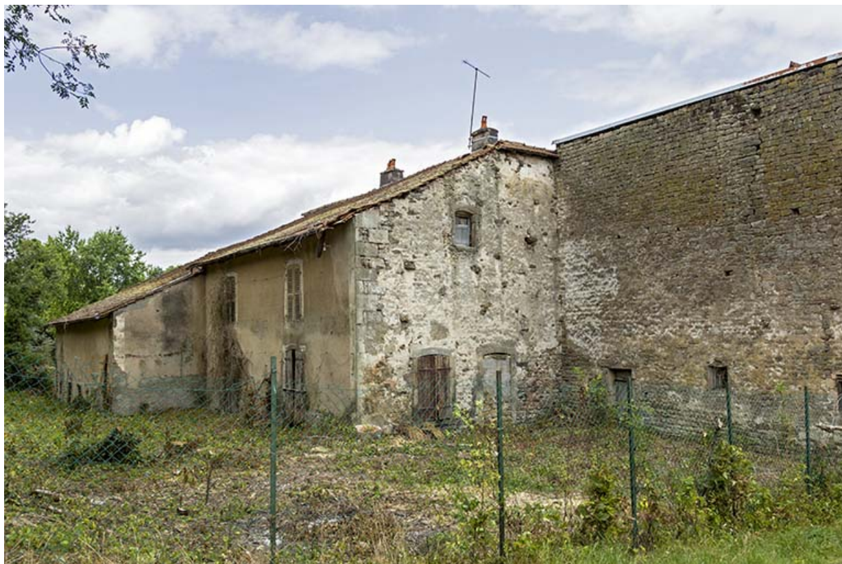
Vue générale sur la façade postérieure.
