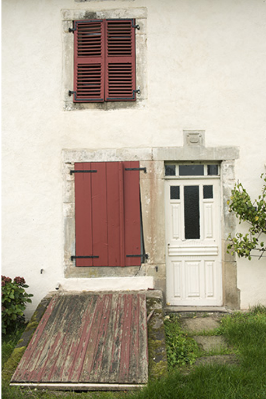
Maison disposant d'un sous-sol.
