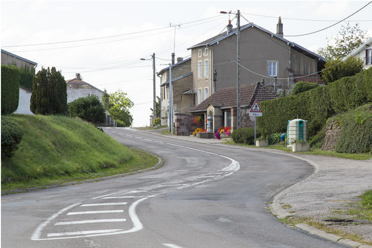
Vue générale de la Grande rue.
