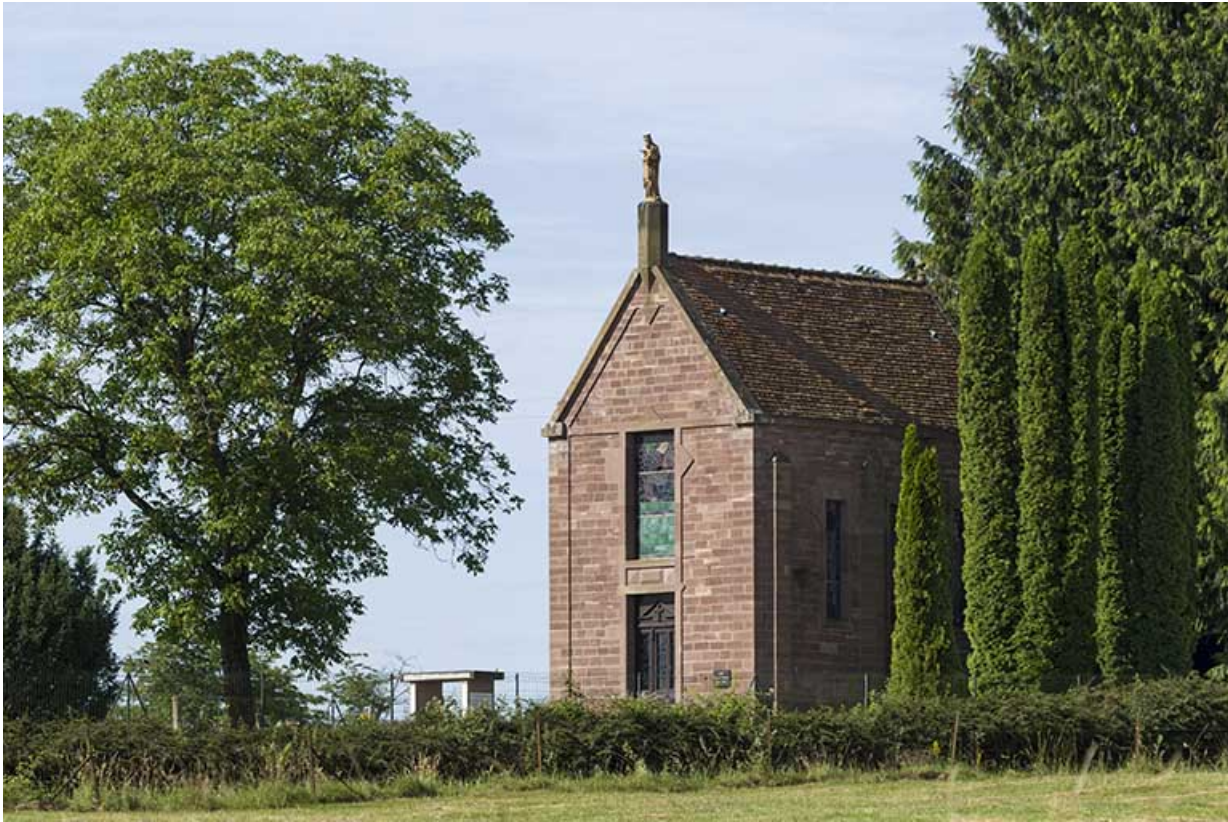
Façade principale de la chapelle.
