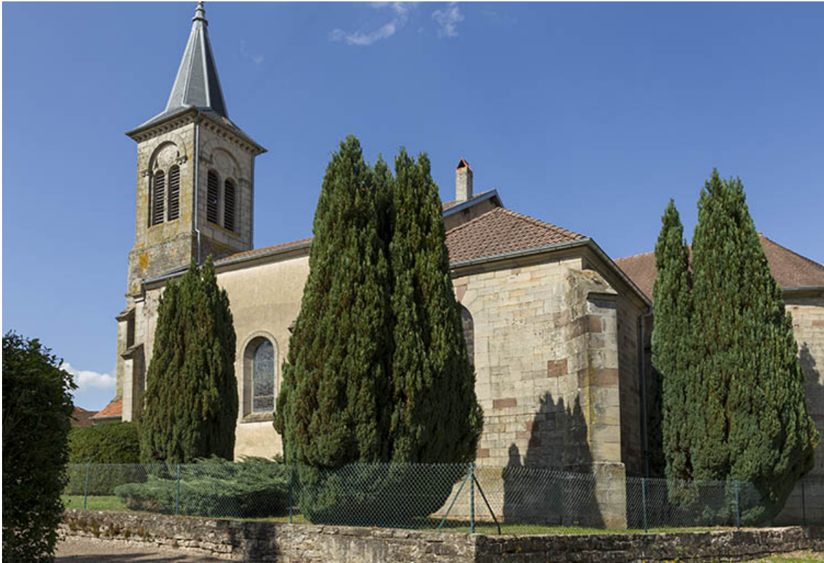
Façade latérale sud de la nef.
