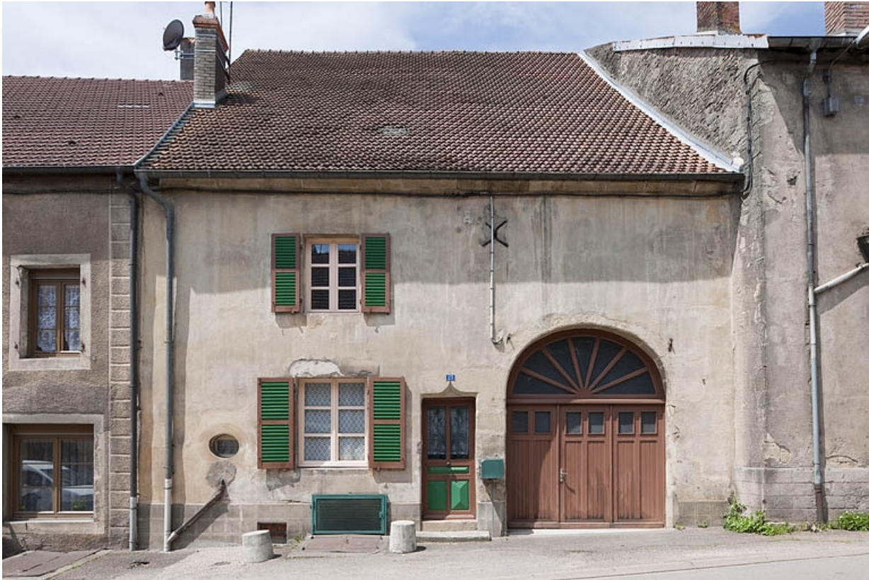
Ferme, 23 Grande Rue : ferme à deux travées.
