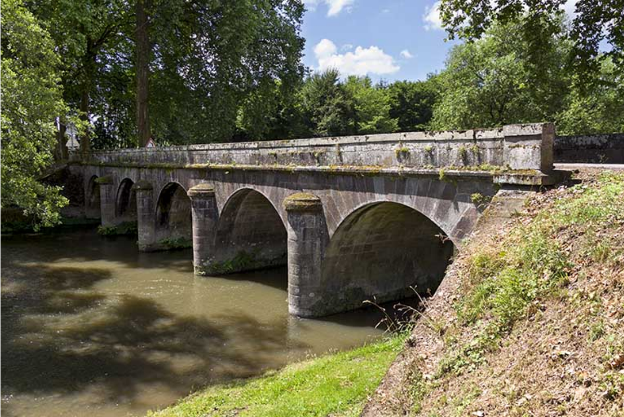
Vue du pont en amont.
