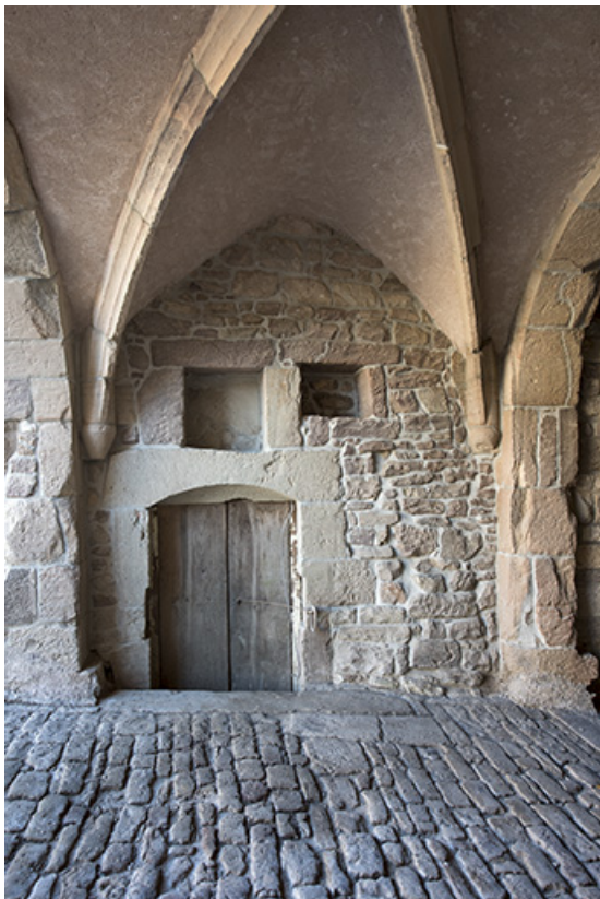
Détail des voûtes.
