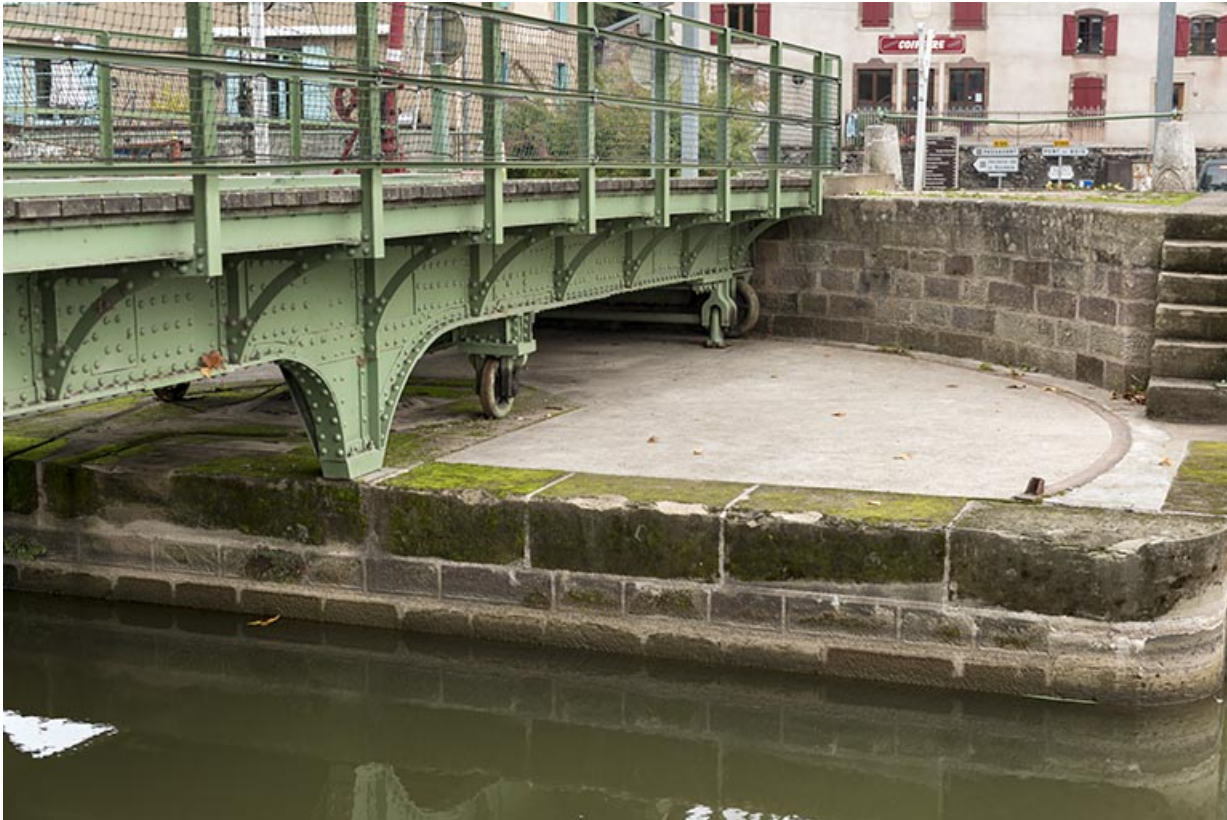
Détail de la plateforme maçonnée.
