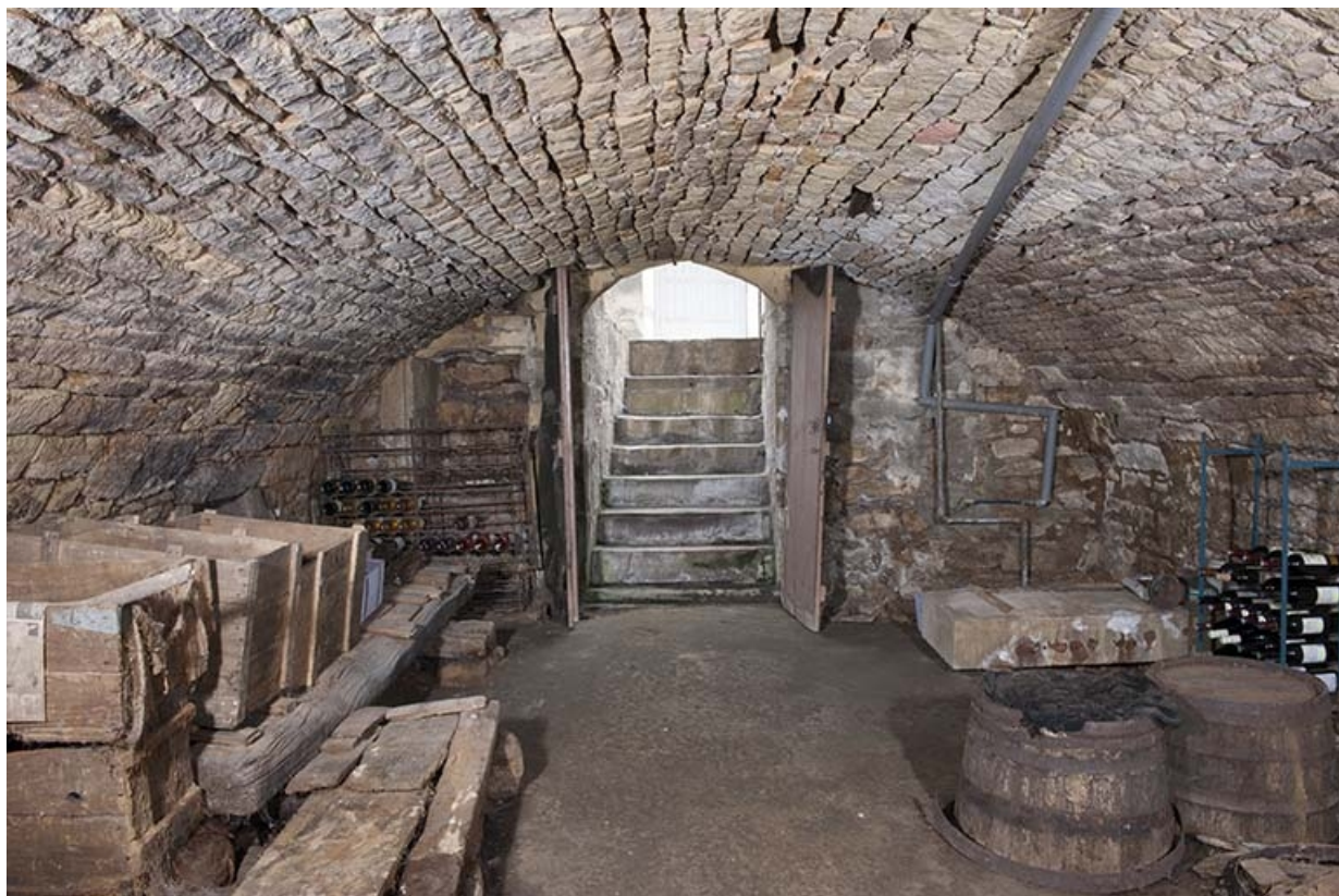
Sous-sol, en direction de l'entrée.
