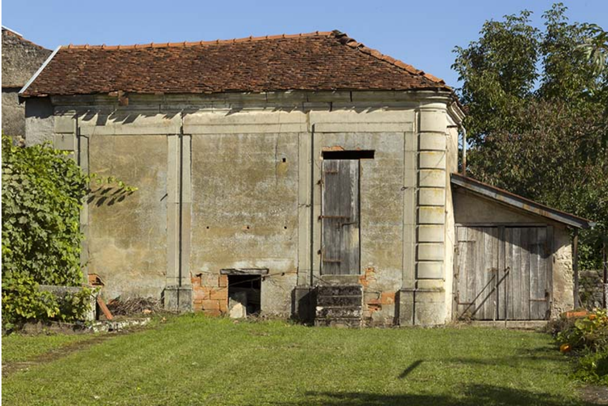
Façade sud de l'édicule du jardin.
