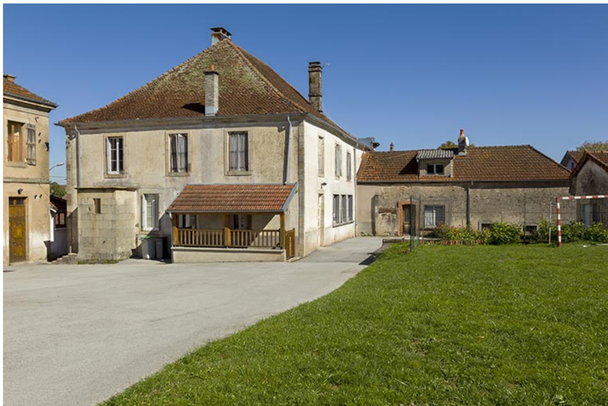
Façade postérieure de la mairie.
