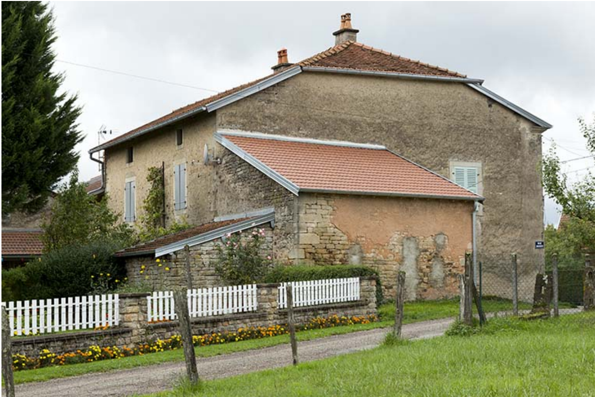
Ferme transformée en maison.
