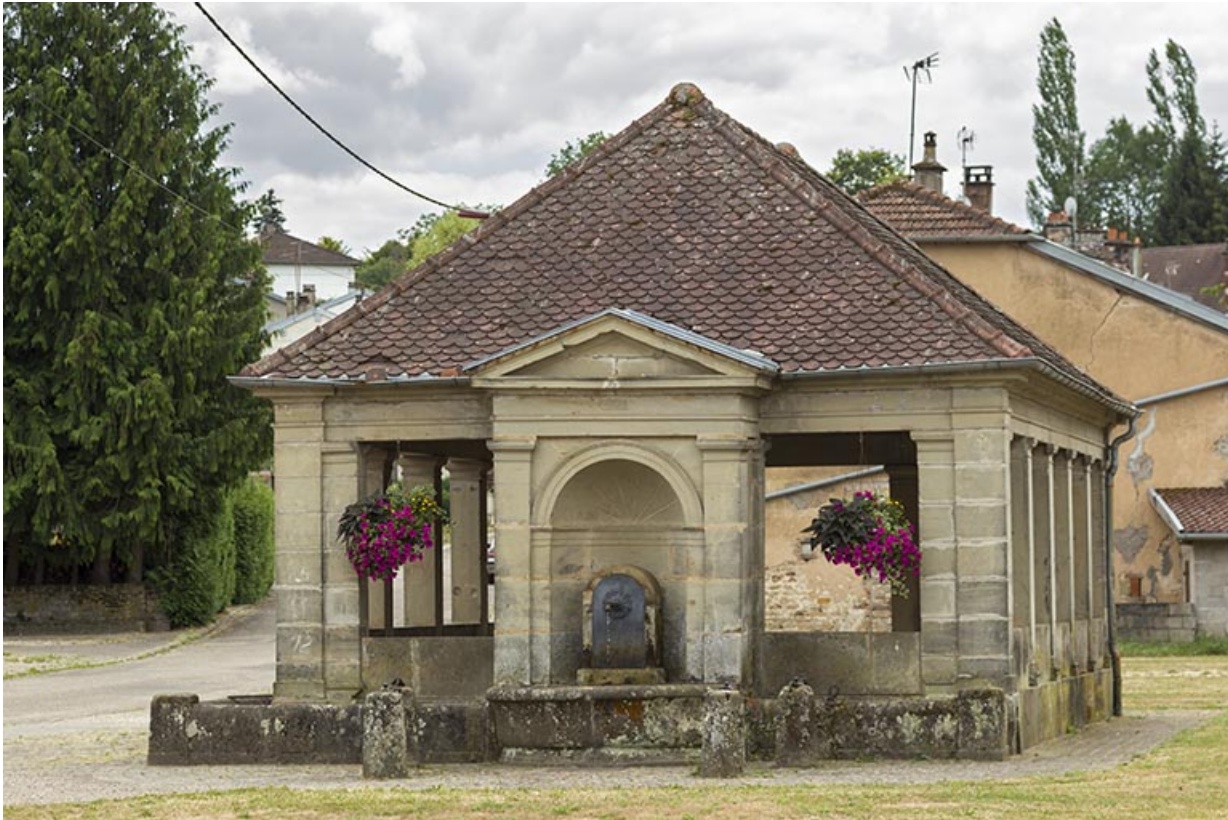
Fontaine-lavoir de la rue Charrière de Vougécourt.
