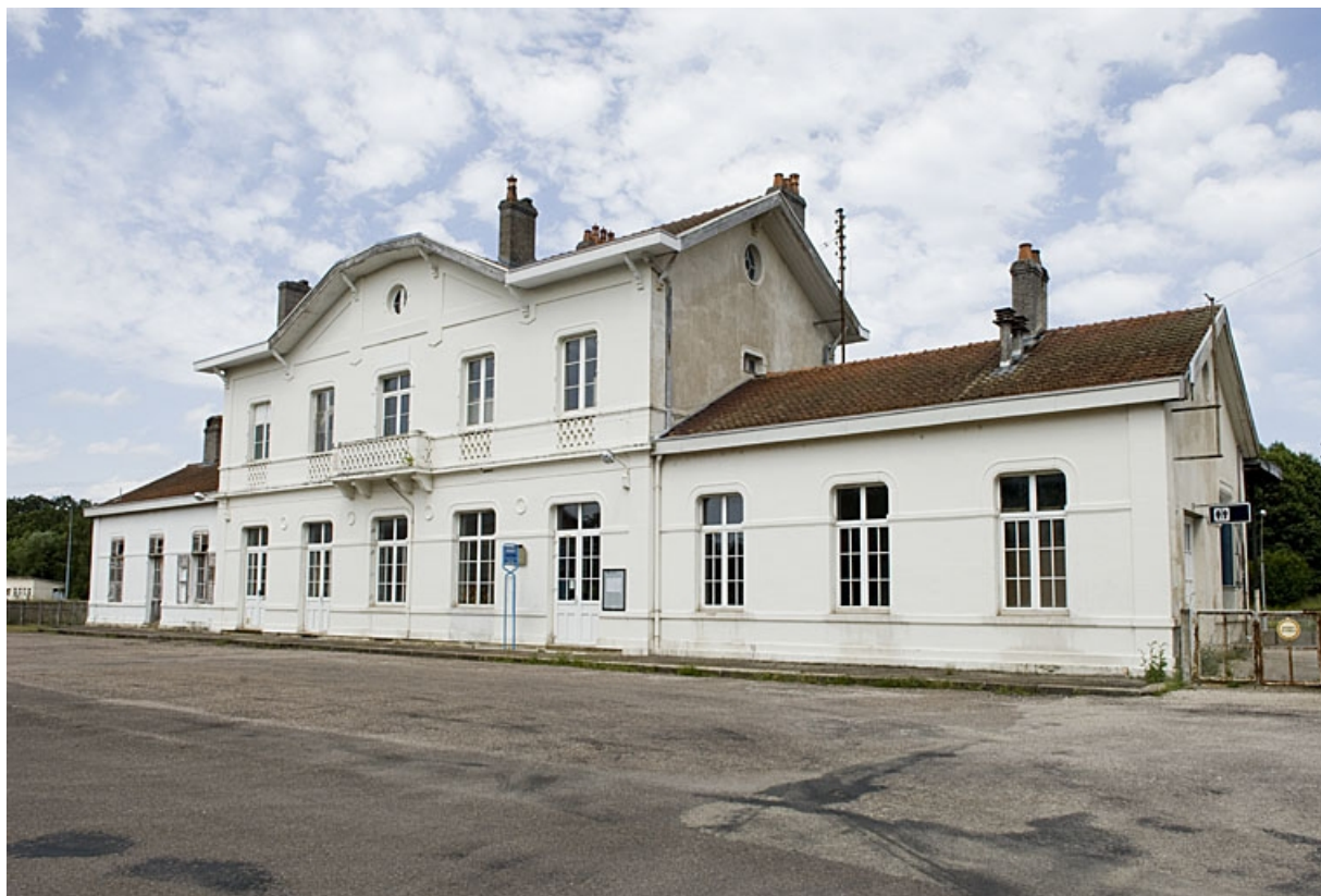
Bâtiment des voyageurs : vue générale depuis l'esplanade.
