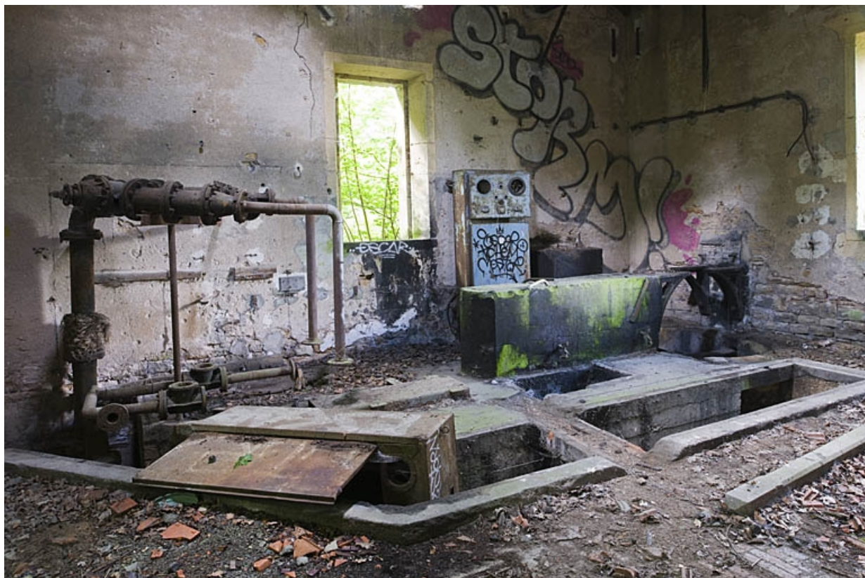
Station de pompage : Intérieur.
