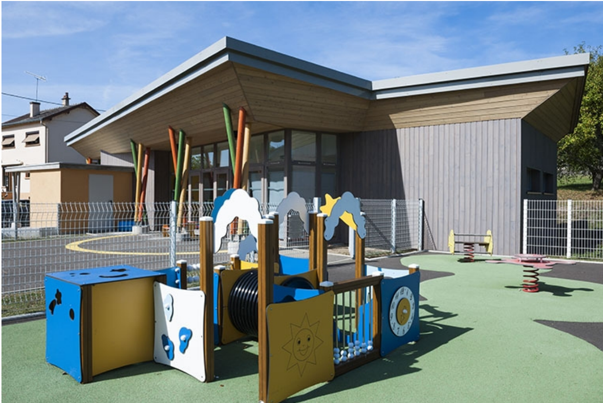
Vue générale de la crèche.
