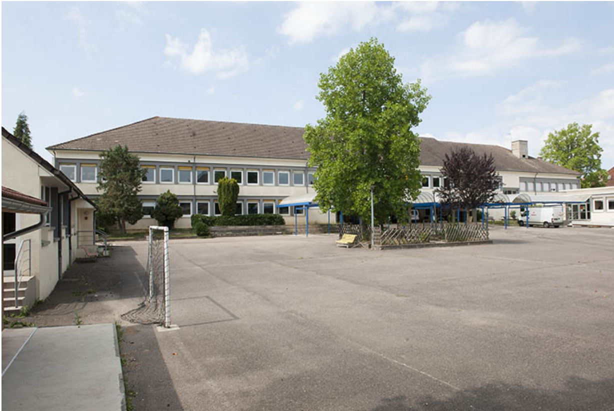
Vue générale sur la cour.
