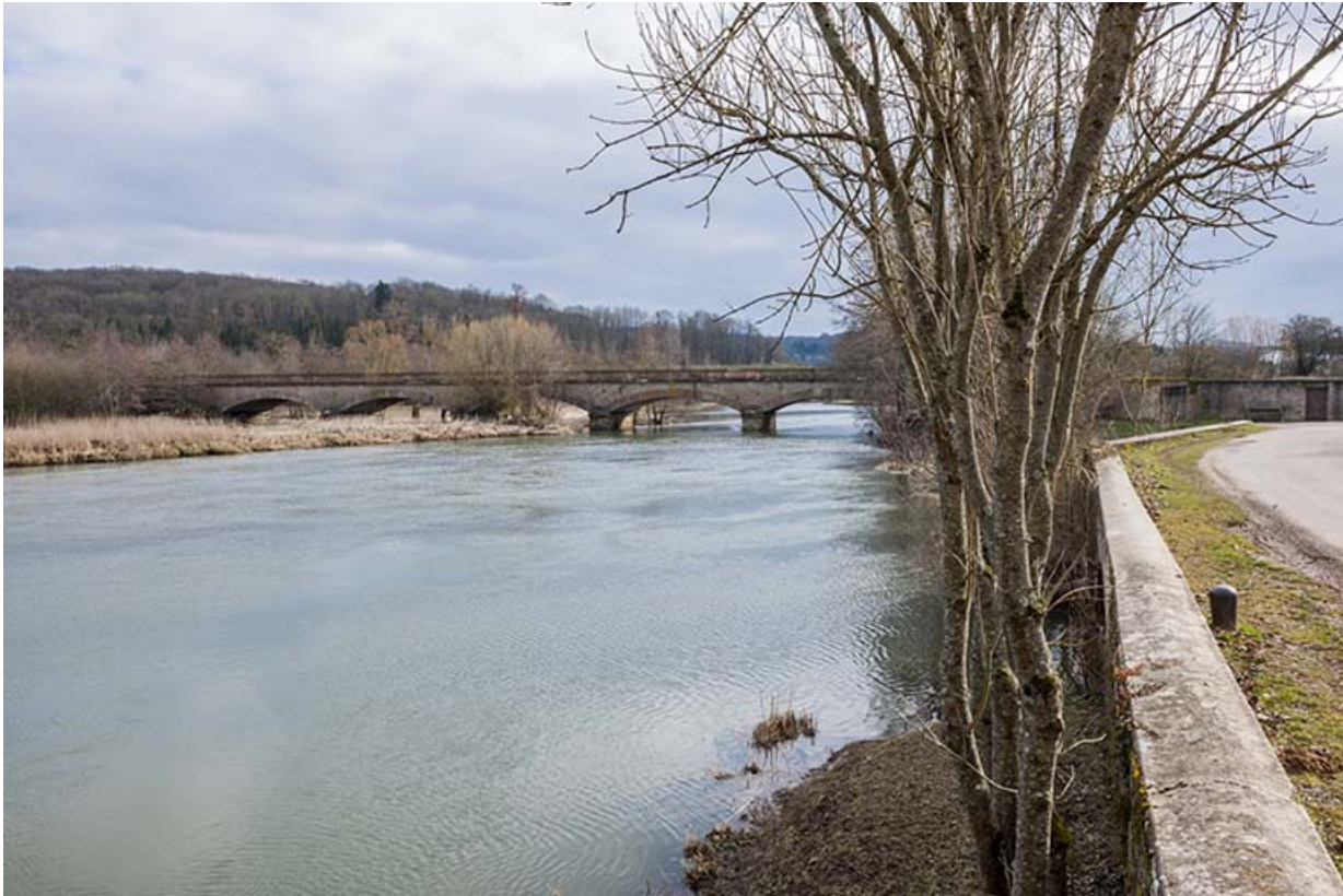
Pont ferroviaire sur la Lanterne (ligne Nancy-Gray).
