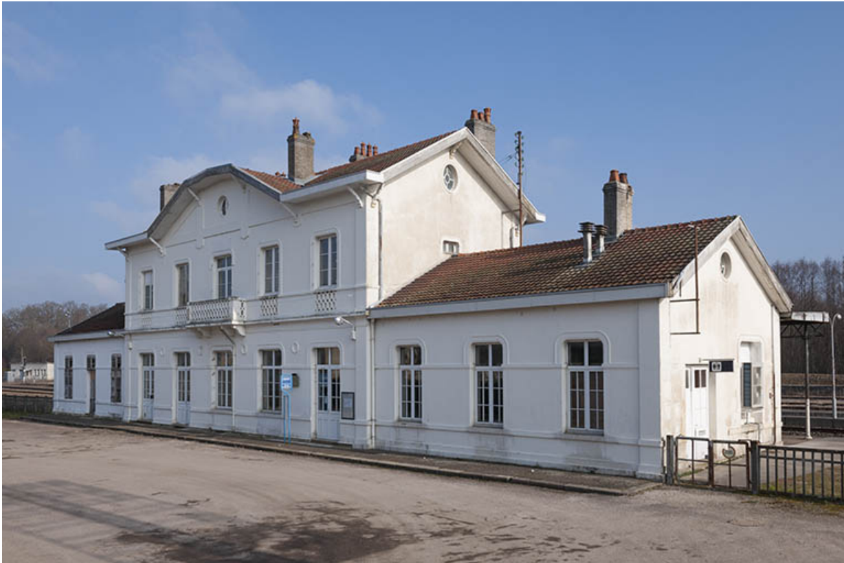
Port-d'Atelier : vue générale de la gare. 70, Faverney
