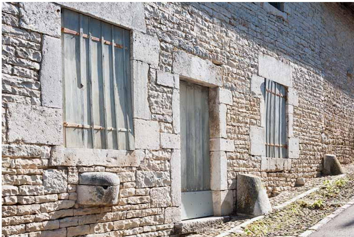
Baies de la façade ouest
