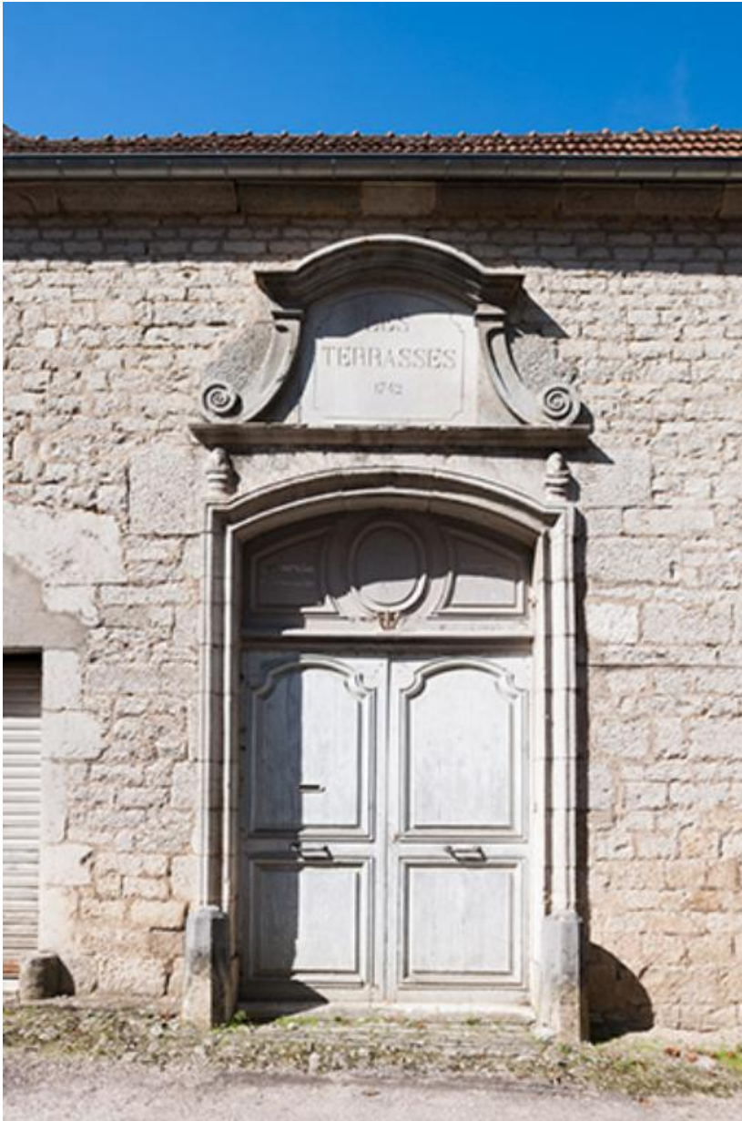
Porte du 6 rue du Bourg
