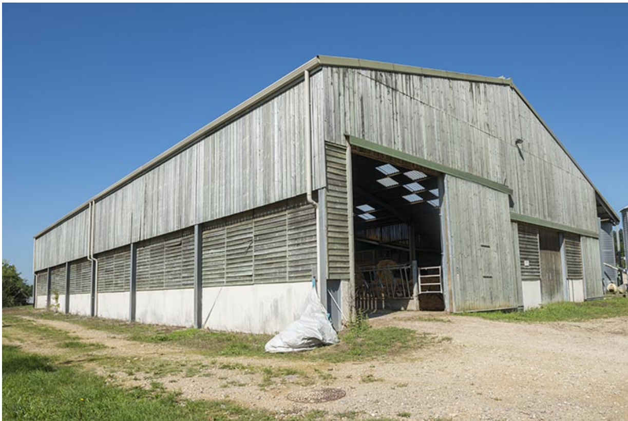
Angle sud-est du bâtiment de production laitière.
