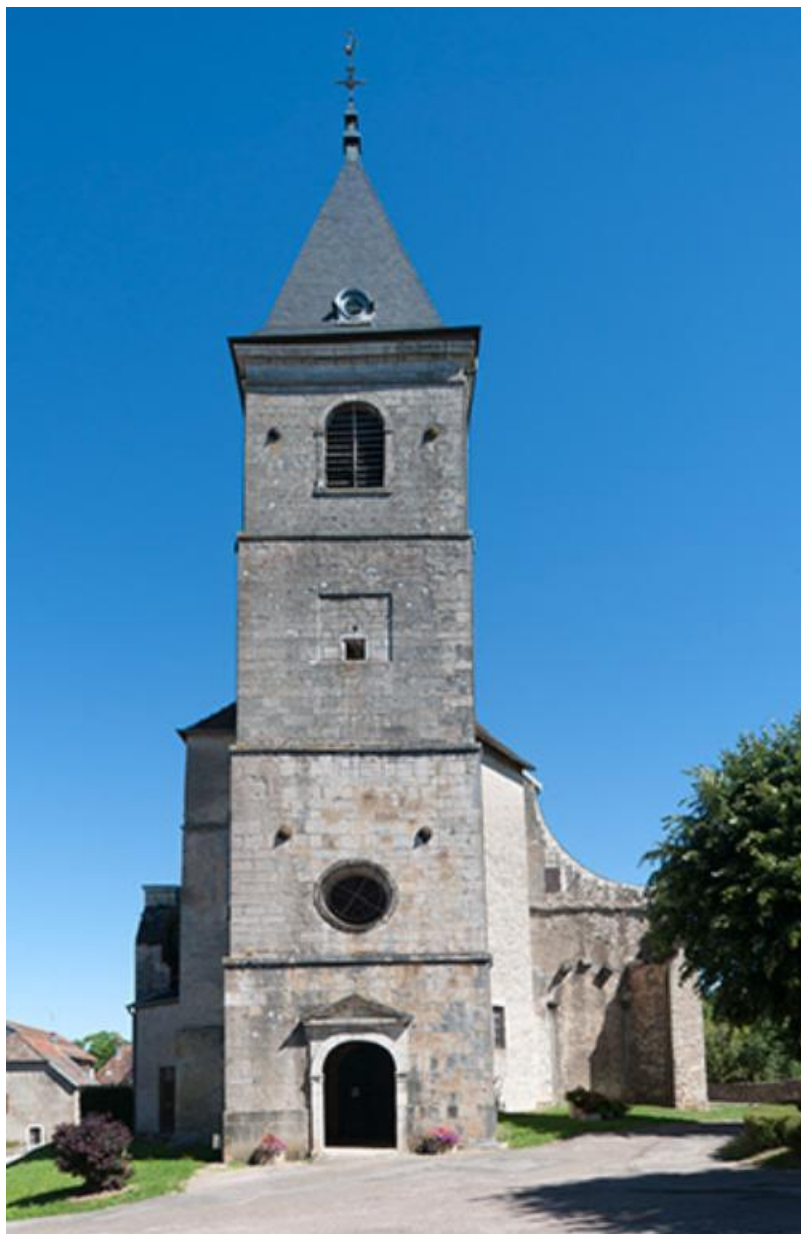
Façade ouest de l'église
