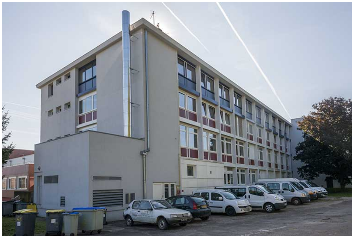
Chaudière à l'angle nord-ouest de l'externat.
