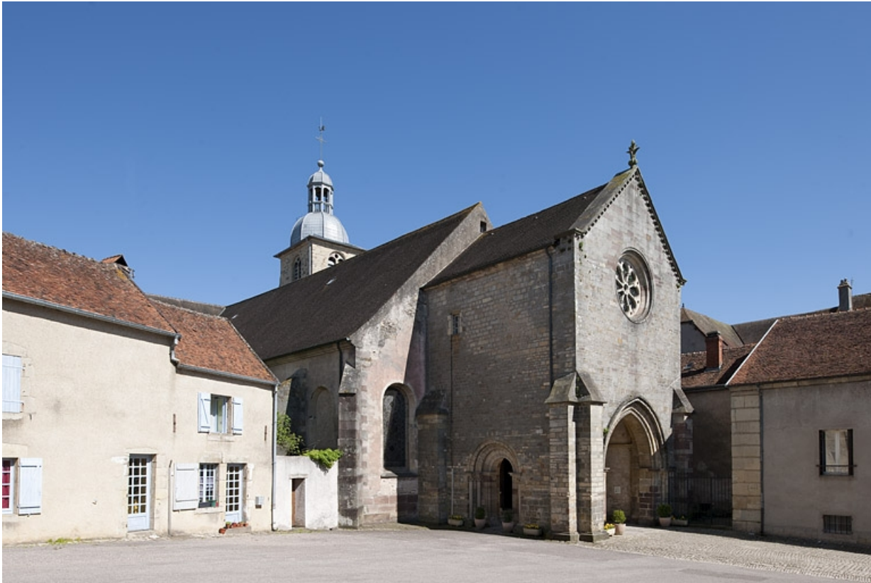
Vue générale depuis la place Sainte-Gude.
