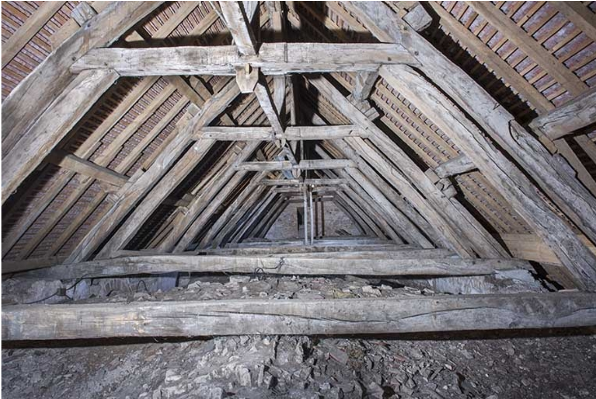
Vue d'ensemble de la charpente.
