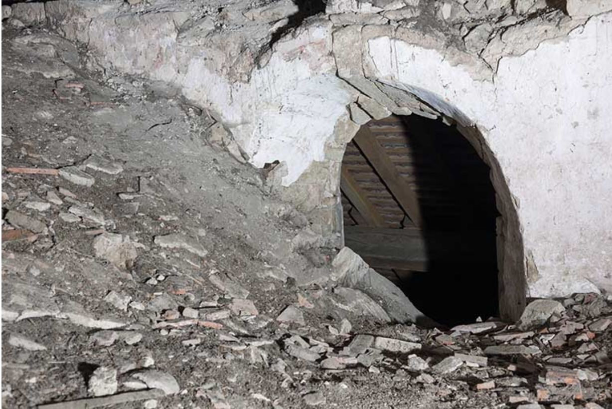
Ancienne baie au-dessus de la voûte.
