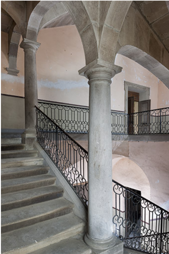
Intérieur : le grand escalier.
