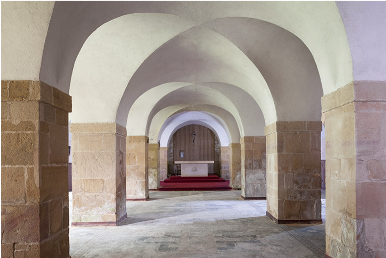
Intérieur : l'étage de soubassement aménagé en chapelle.
