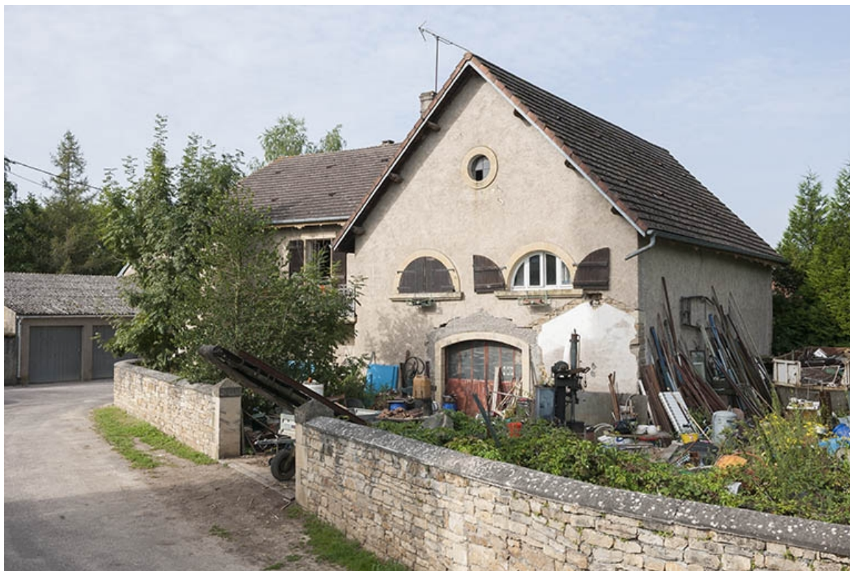
Façades latérale droite et postérieure.
