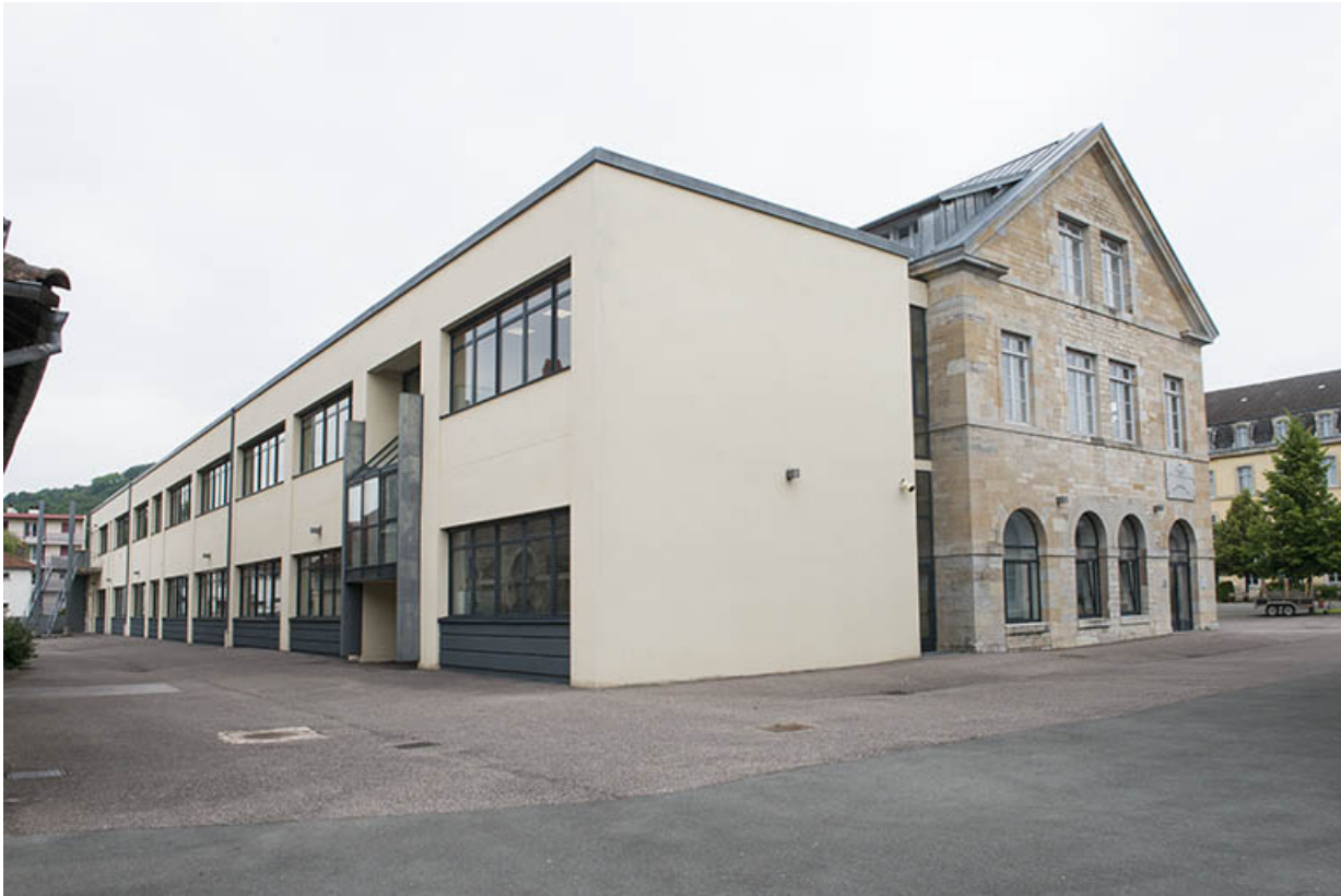
Pignons sud des deux parties de l'externat.
