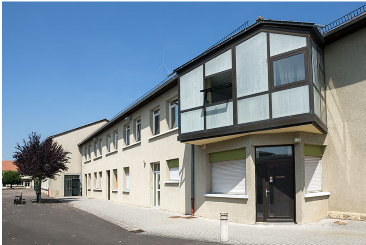
Angle sud-ouest à l'entrée de la cour.
