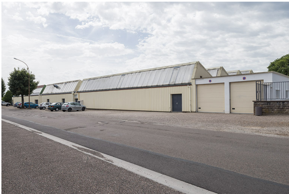
Ateliers : façade postérieure.
