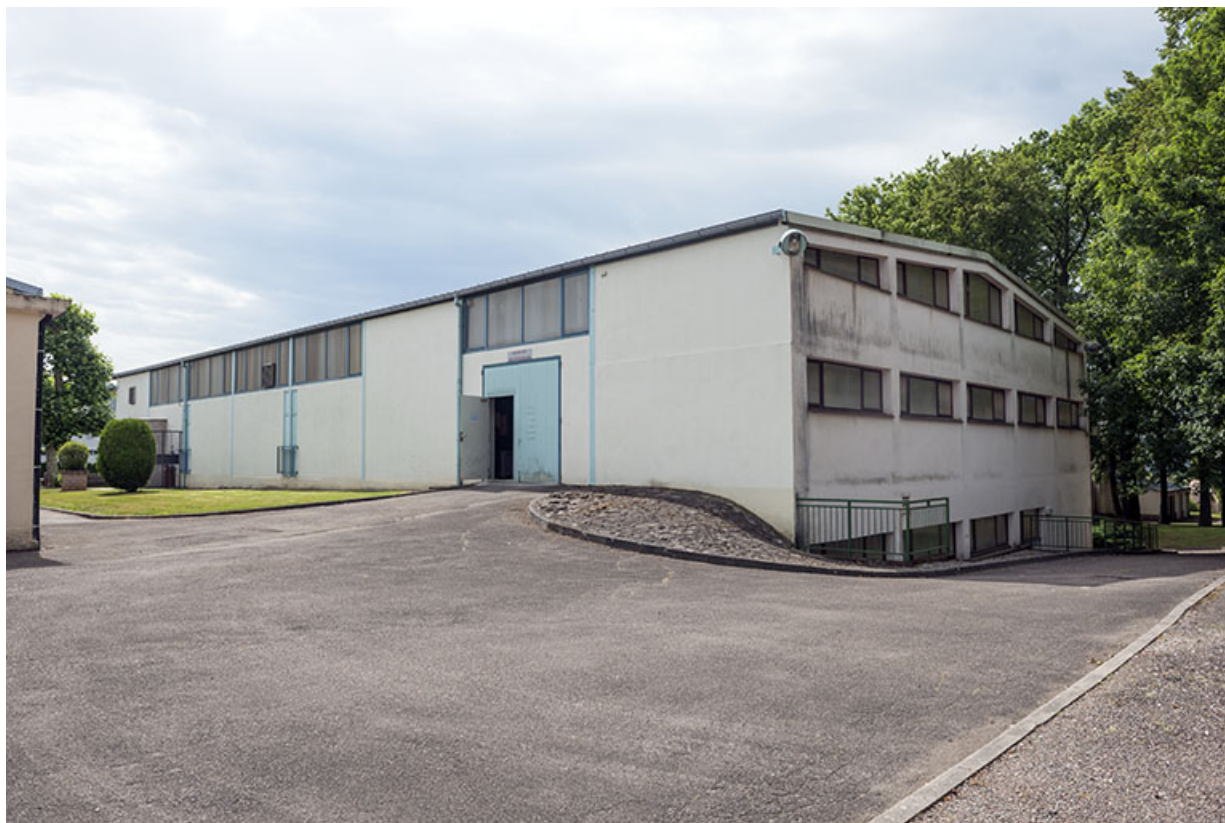
Atelier de gros-oeuvre : façade antérieure.
