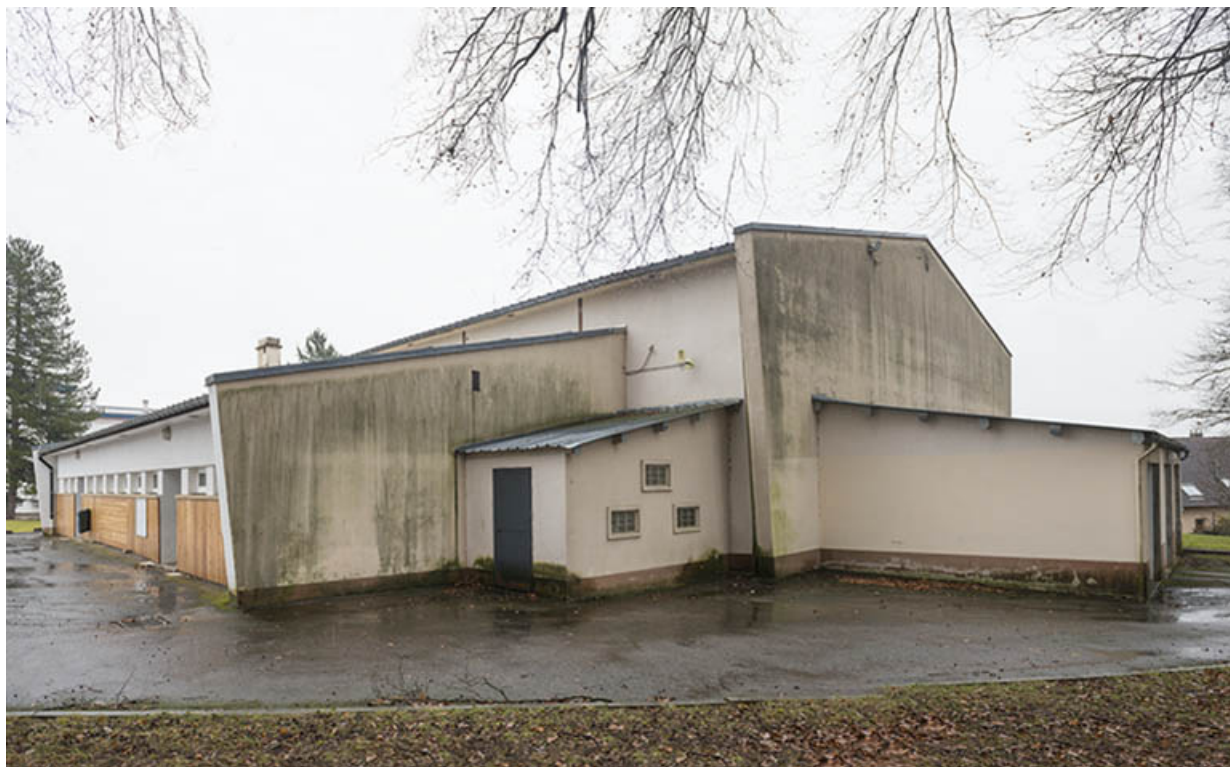
Angle nord-ouest du gymnase.
