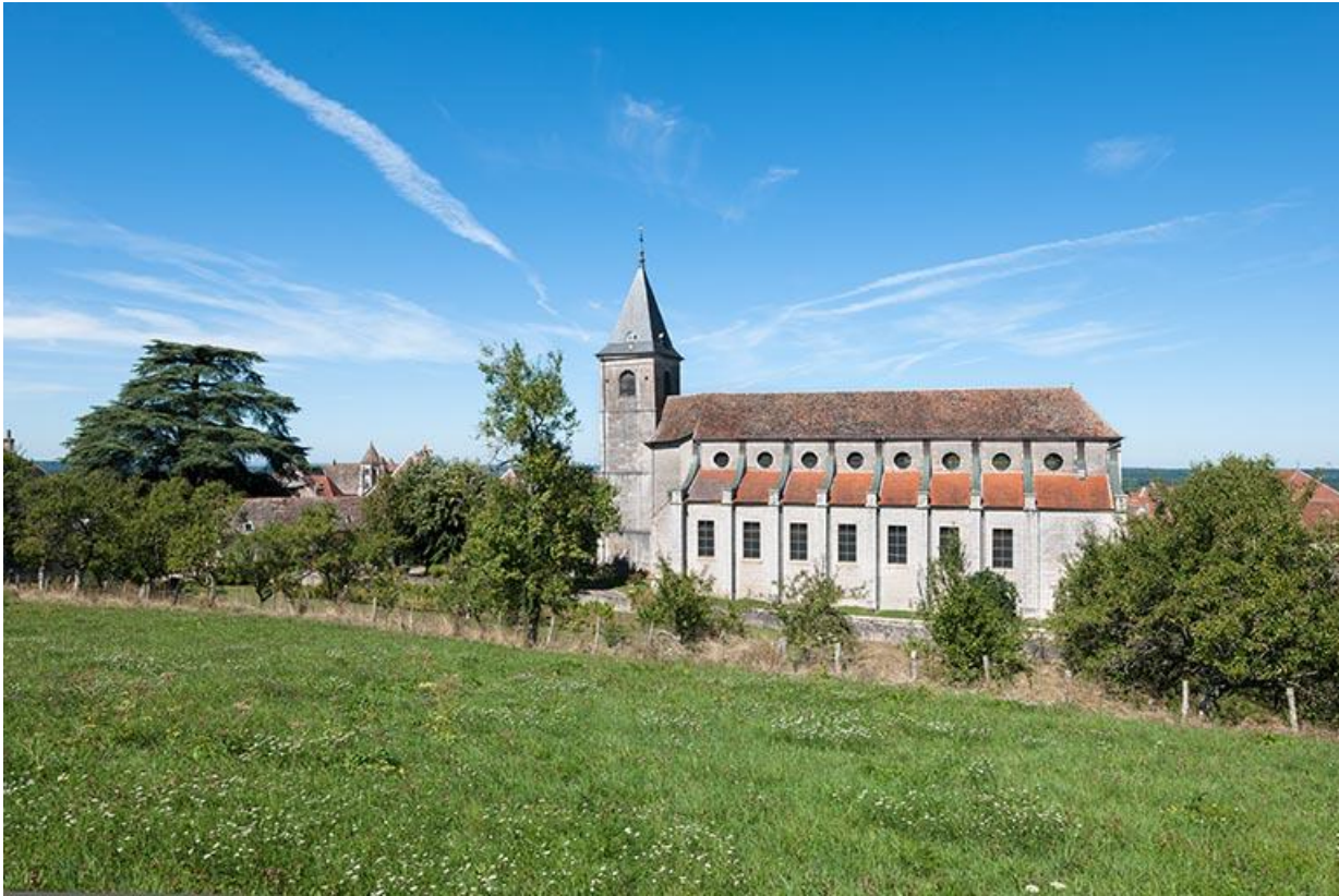
Vue générale sud de l'église
