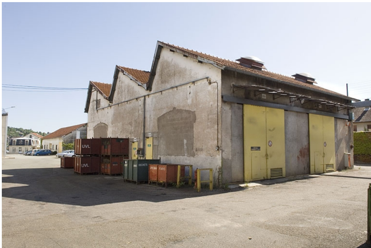
Salle des machines et chaufferie (usine Dollé).
