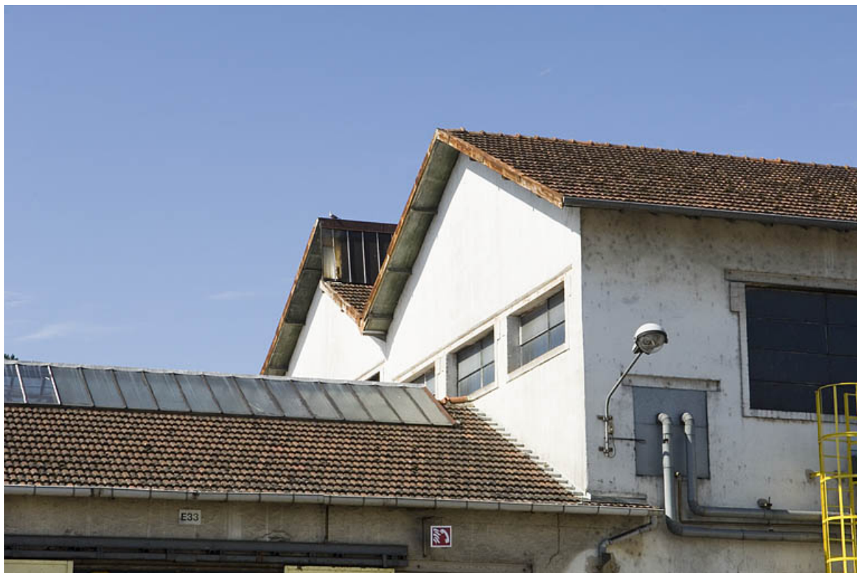
Toiture d'un magasin industriel.
