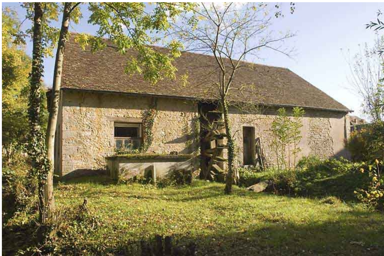
Façade postérieure du moulin.
