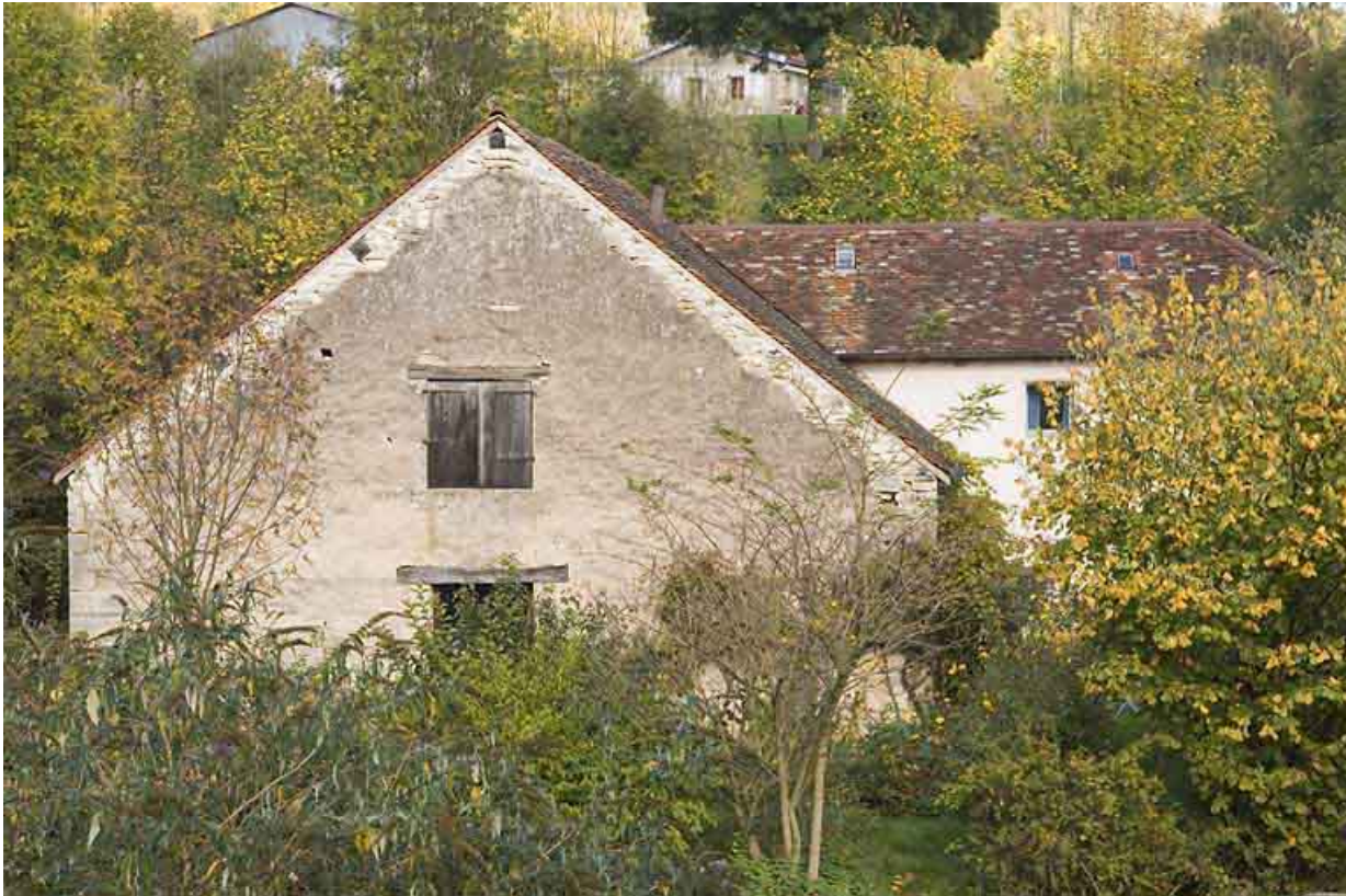
Pignon sud du moulin.
