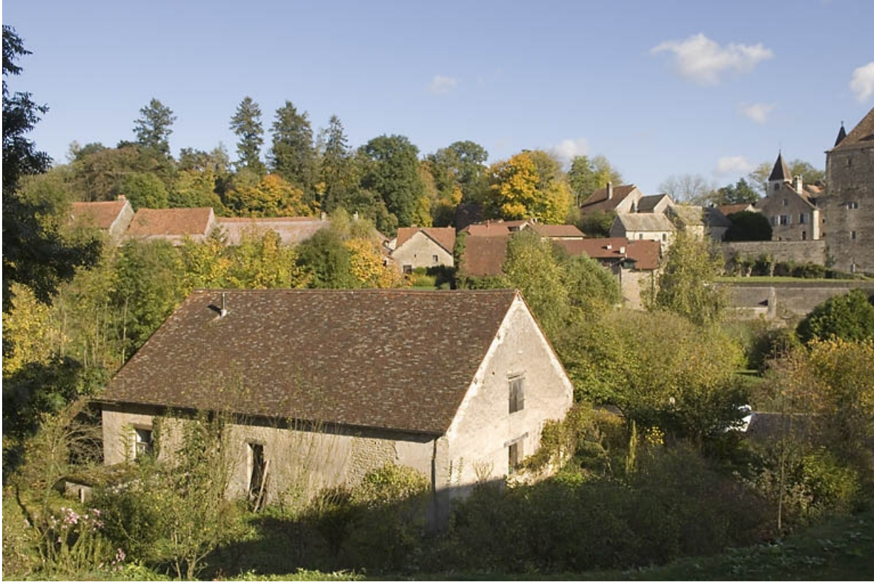
Vue plongeante depuis l'ouest.
