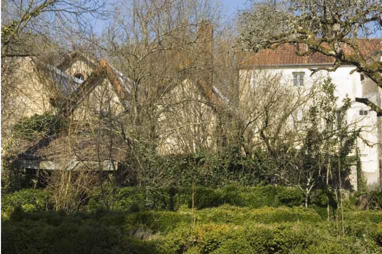
Atelier de fabrication et logement depuis l'ouest.
