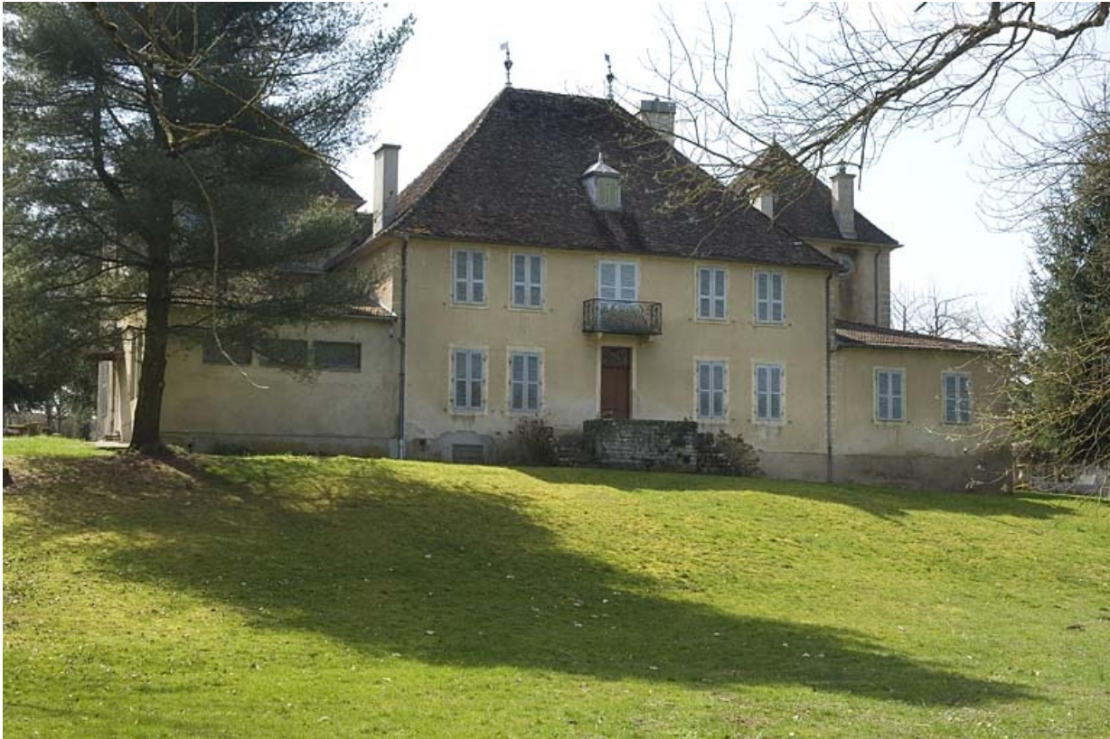
Façade postérieure du logement patronal.
