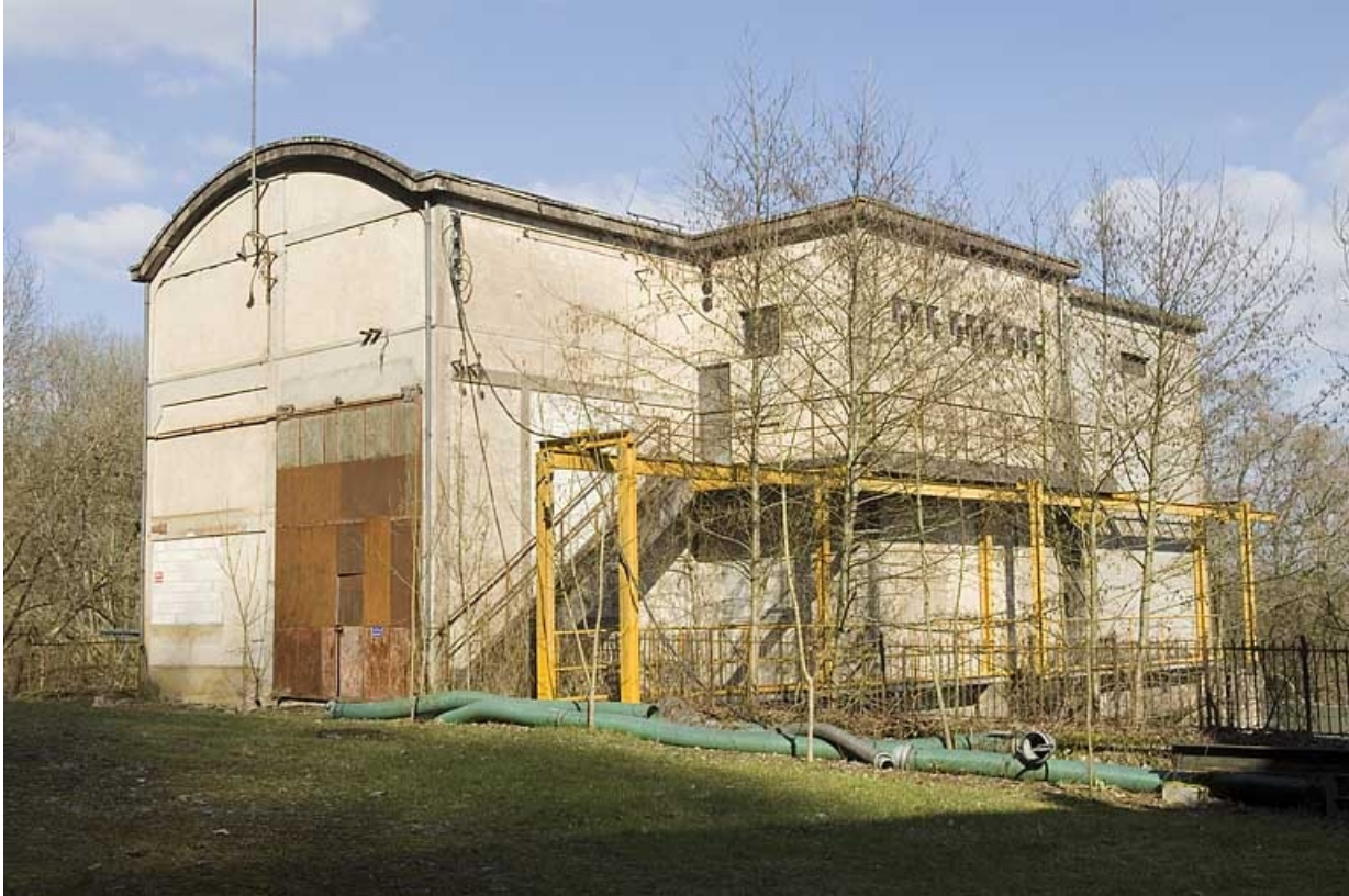
La centrale hydroélectrique vue de trois quarts.
