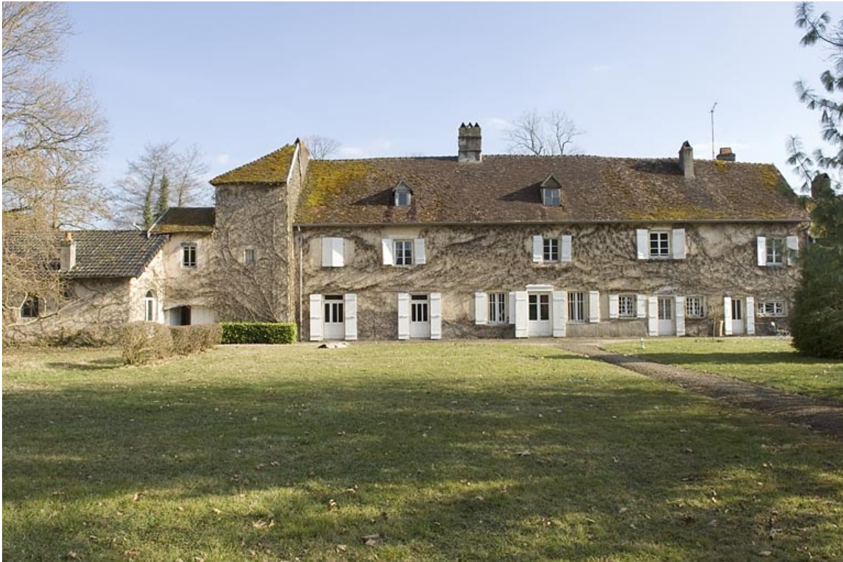
Façade postérieure du logis ouest.
