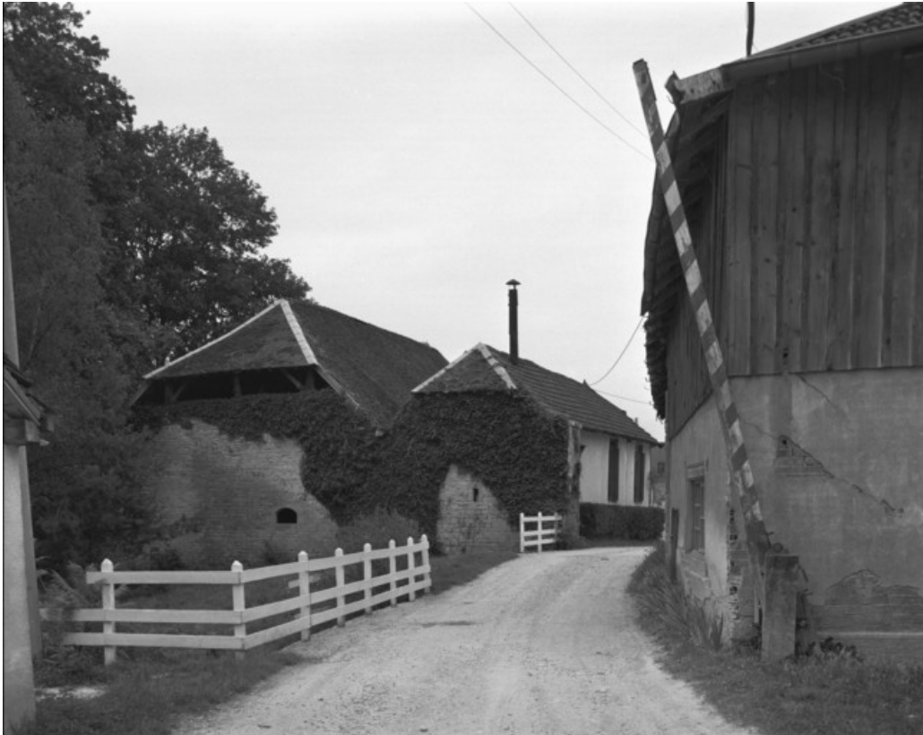
Halle à charbon sud depuis l'entrée en 1989.
