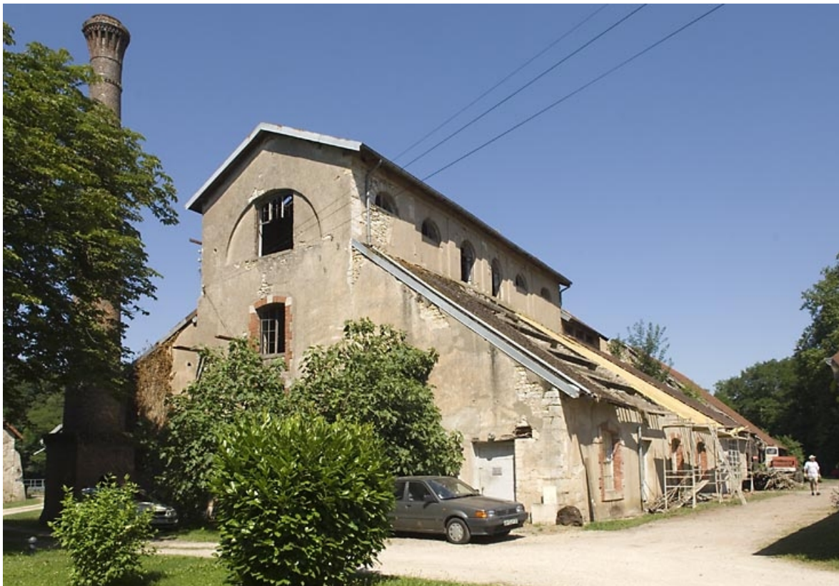
Le haut fourneau vu depuis le sud-est.
