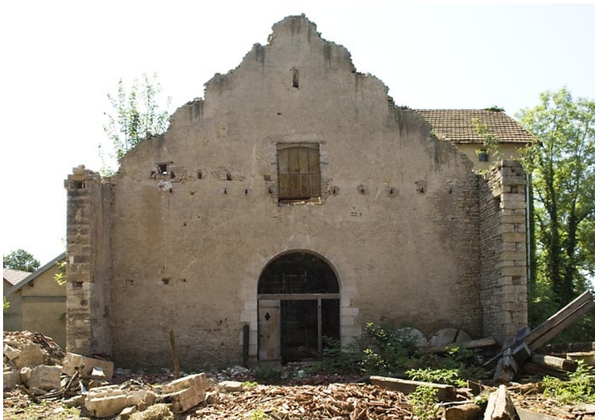
Mur sud de la halle à charbon.
