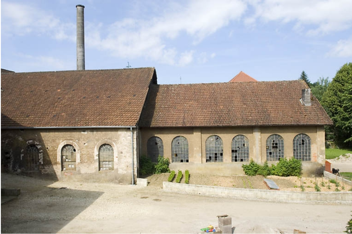
Façade est de l'atelier de fonderie.
