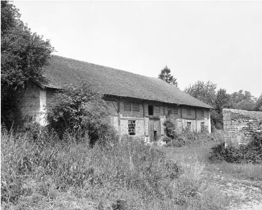
La halle à charbon en 1981.
