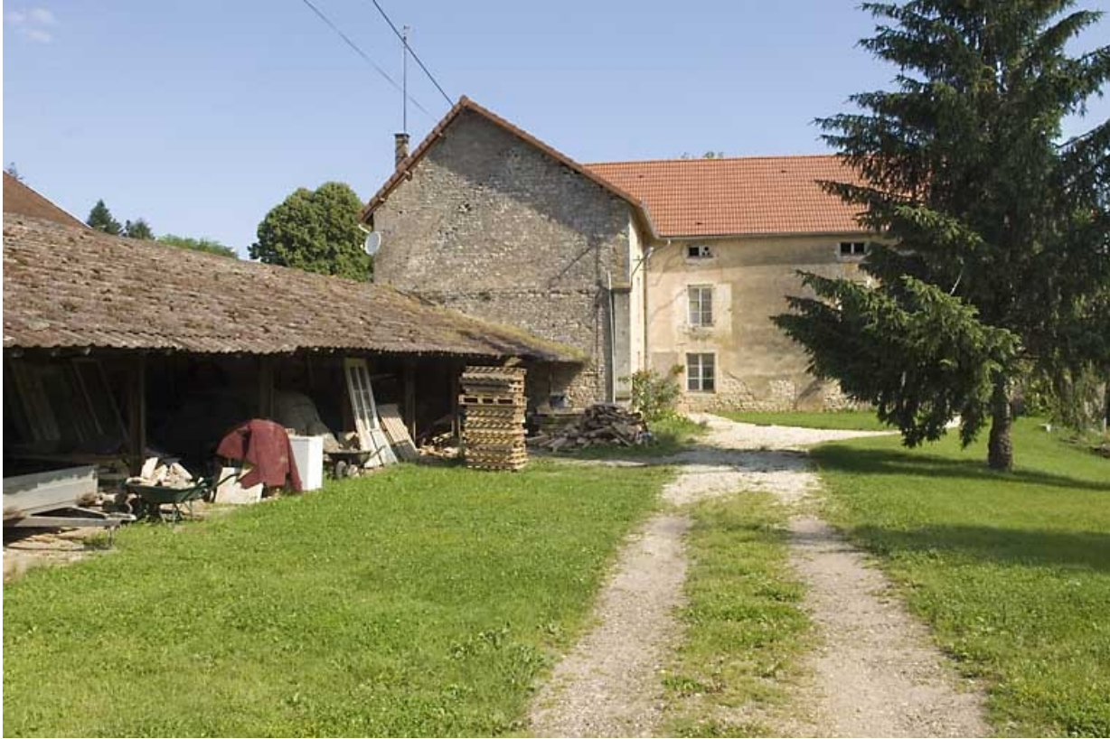
Appentis et logement patronal depuis l'entrée.
